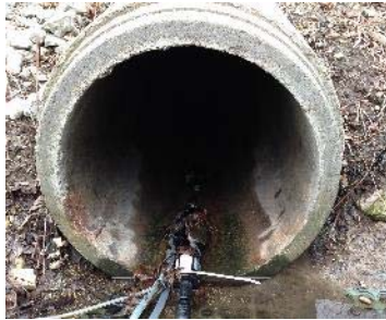
7a. TB7Bin 1.5-ft culvert
